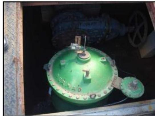
(d) – Válvula de retenção e controle de pressão e registro de manobra.
