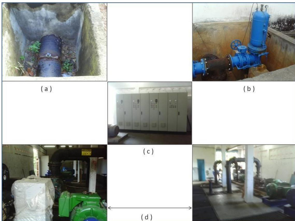
**Figura 0.7** – (a) Medidor de vazão TAP, (b) Válvulas anti-golpe de ariete, (c) Quadro de comando das bombas e (d) Estação elevatória de água tratada.
